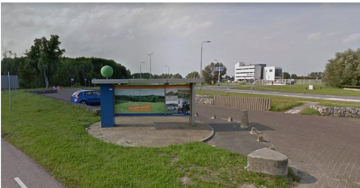
Afb. 22. De parkeerplaats en achterzijde van het informatiebord naast de Wijkertunnel, met rechts op de achtergrond het gebouw van Rijkswaterstaat aan de overzijde van de Amsterdamseweg. Voor de locatie zie afb. 25 (naar Google Earth, opname uit 2017).
